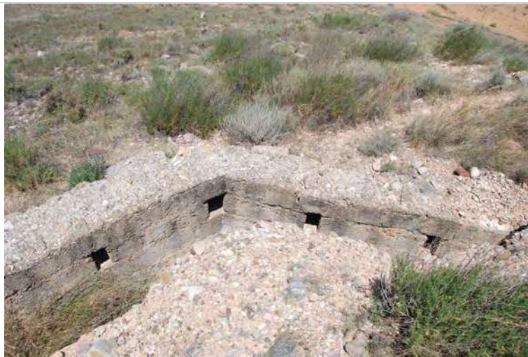
Trinchera fortificada con aspilleras
